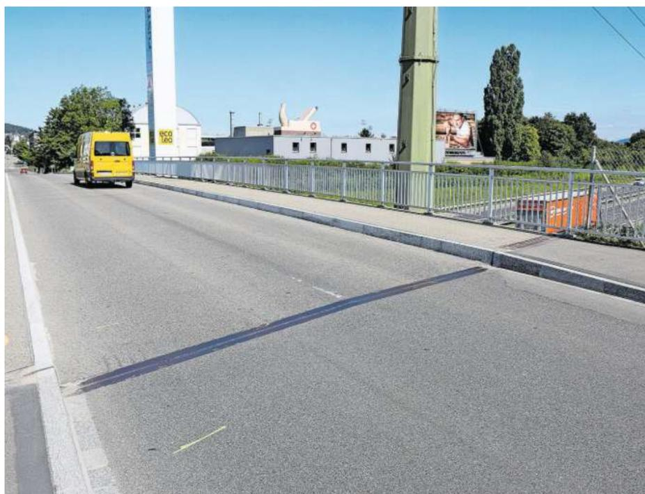
Fahrbahnübergänge sind Bauteile, die Verformungen und Bewegungen ausgleichen.
