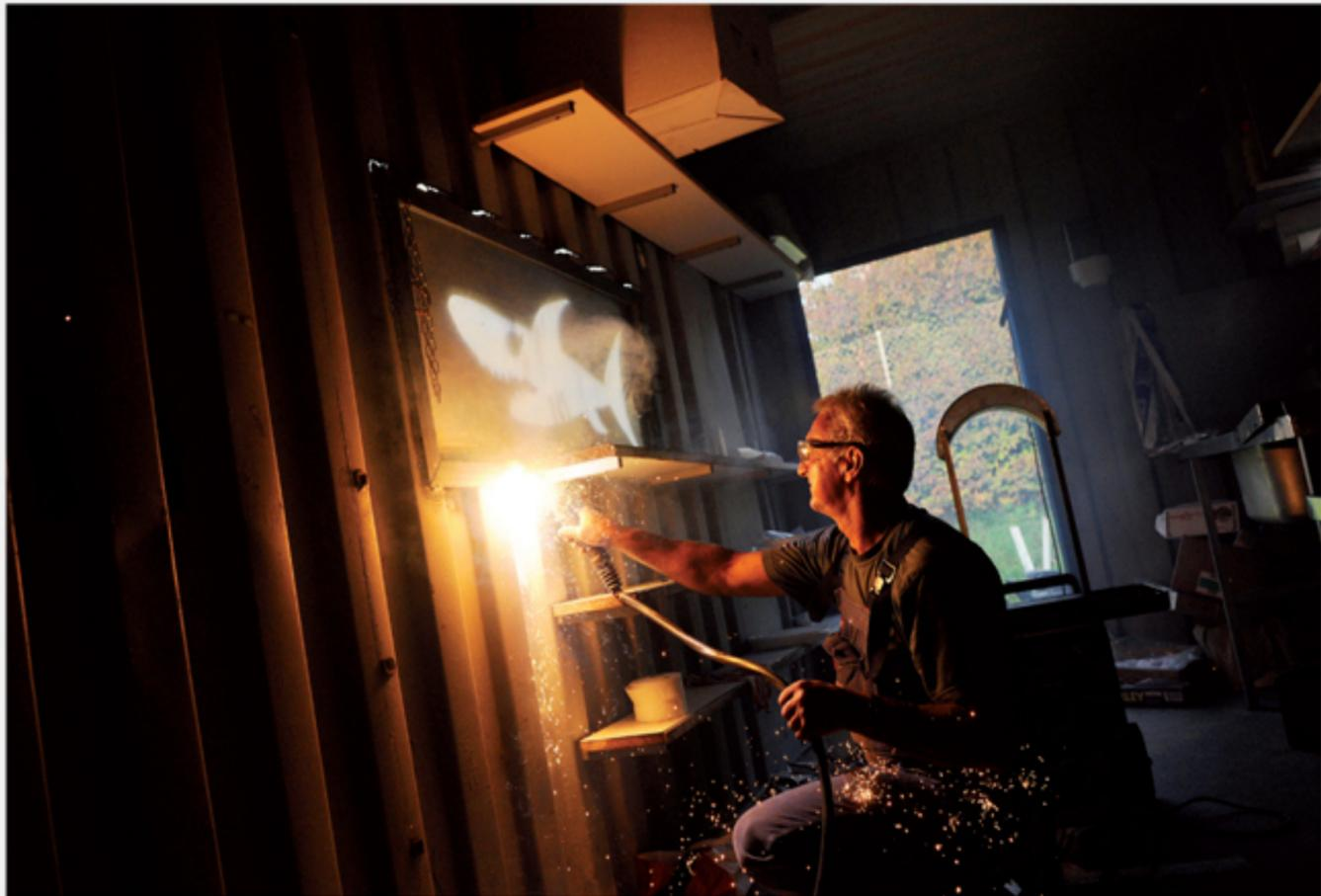
Zerstörung und Neuaufbau zugleich: Martin Brändle setzt – unter dem bissigen Hai(-Fenster) – den Schneidbrenner an und trennt den Küchenteil des Bar-Containers ab. Die so verkürzte Bar wird auch im neuen Zirkuszelt ihren Platz finden. Bilder Heini Schwendener
