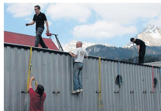
**Teamarbeit ist das A und O:** Alles, was es für den Aufbau des Zeltainers braucht, ist im Winter in den ehemaligen Schiffscontainern eingelagert. In luftiger Höhe wird die Konstruktion für das Zeltdach eingerichtet. Dann legen Martin Sailer und seine Helfer die Zeltblache aus, ziehen sie auf und befestigen sie mit Spannsätzen an den Containerwänden.
